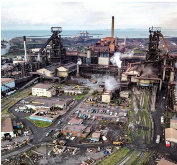
解体前の5号、4号高炉の外観
