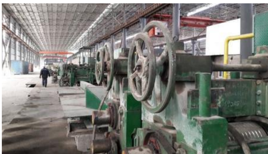
Sin Yuan Steel 社圧延ライン
